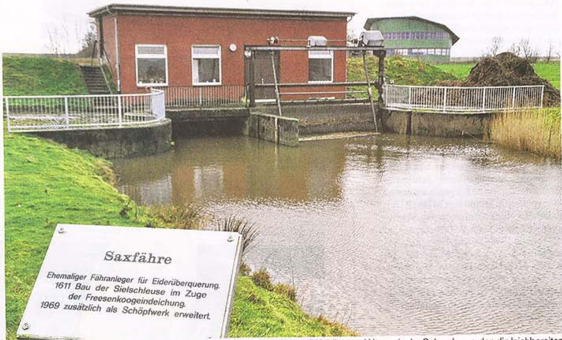
Das Schöpfwerk Saxfähre. In den Pumpen mit einer Leistung von bis zu 2,7 Kubikmeter Wasser in der Sekunde, werden die laichbereiten Blankaale geradezu geschreddert. UME
