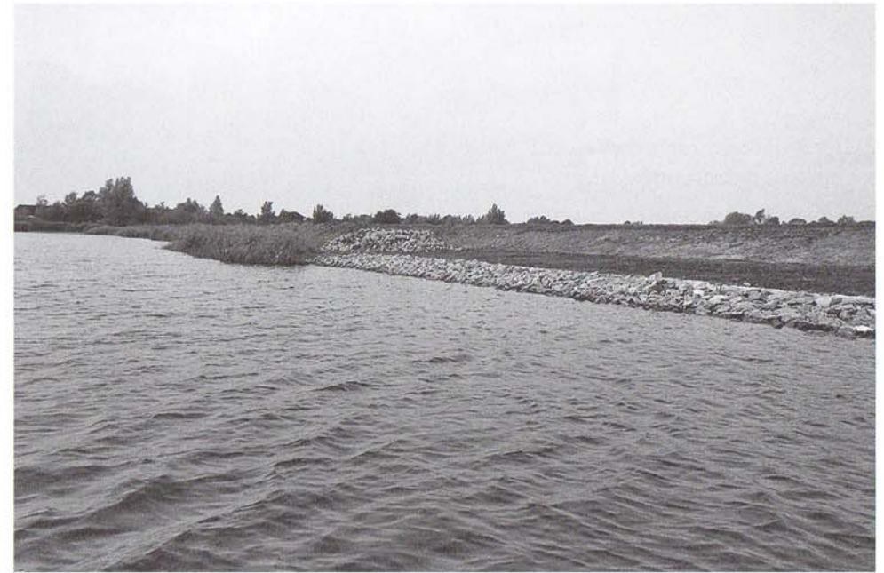
Steinschüttungen und gerammte Pfähle ersetzen die Uferbefestigung durch Reet Toter Arm Friedrichstadt, 2016
